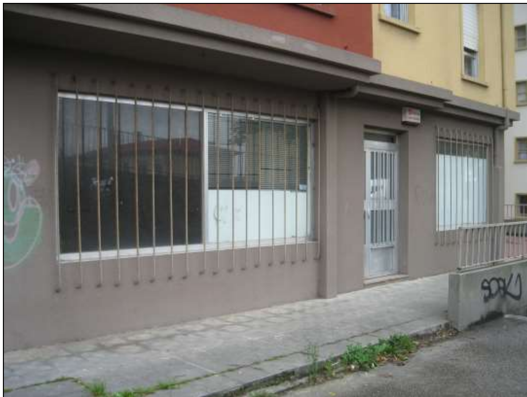
Fachada posterior y puerta de acceso - Detalle
