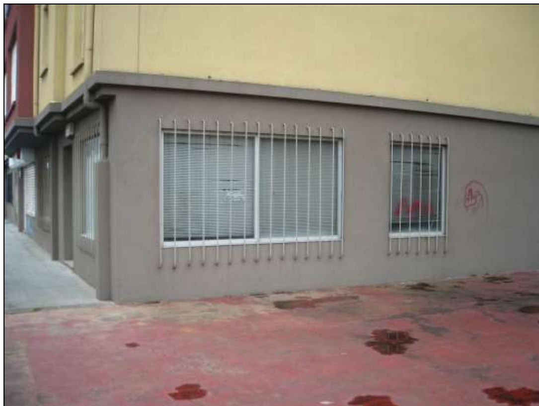
Fachada lateral – Detalle
